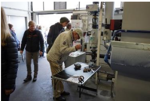
9 Besucher im Heizwerk Malchin (Photo: A. Haberl)
